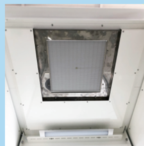
▲HPEA フィルター搭載 陽圧装置（天井）
